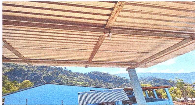
Foto 4: Reparación de cableado eléctrico
