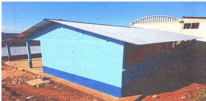
Foto 1: sustitución de lámina por lámina troquelada.
