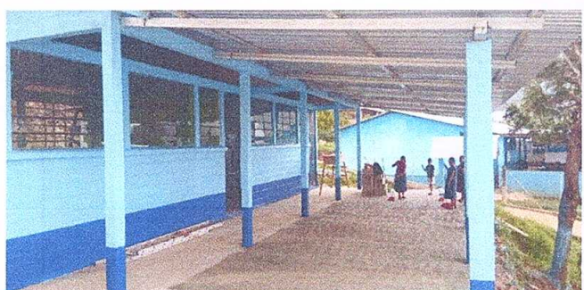
Pintura en muros exteriores
