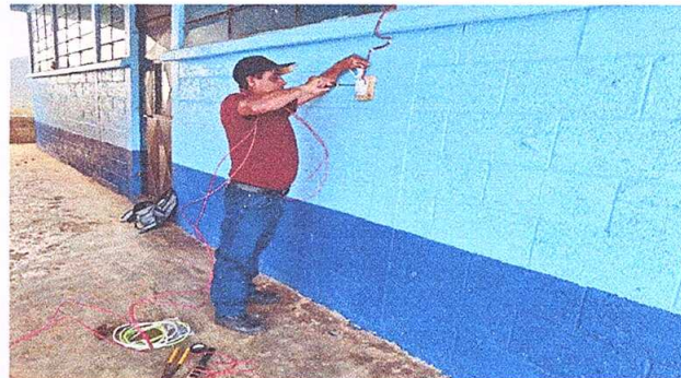
Foto 4: Reparación de cableado eléctrico
