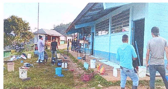
Pintura en muros exteriores
