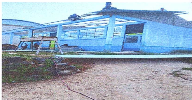
Foto 1: sustitución de lámina por lámina troquelada.
