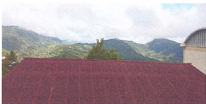
Foto 1: sustitución de lámina por lámina troquelada.
