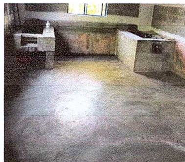
Foto 6: Colocación de piso de torta de concreto en mal estado
