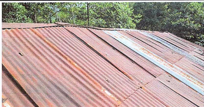
Foto1: Láminas y capotes en malas condiciones
