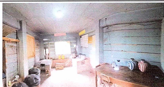
Foto 3: Paredes con tres hiladas de bloc, lo demás con madera en cocina y aulas.
