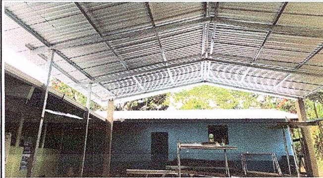
Foto 2: Estructura de techo instalado
