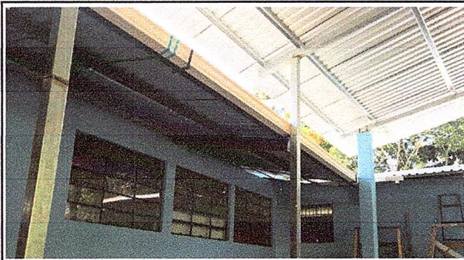
Foto 4: Canales instalados
