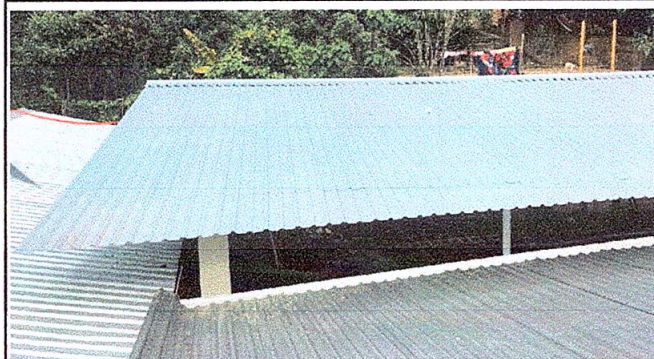
Foto1: Láminas y capotes instalados
