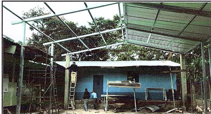
Foto 2: Instalación de estructura de techo
