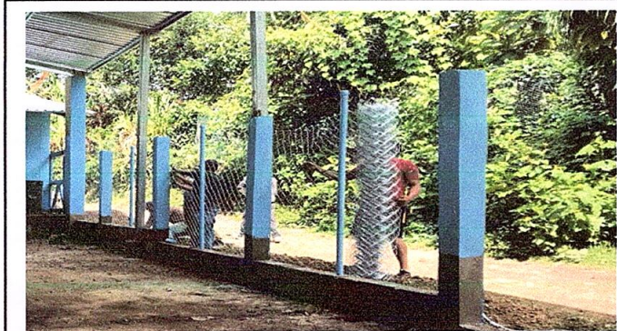
Foto 3: Instalación de perímetro
