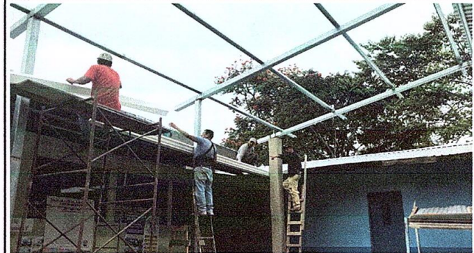
Foto 4: Instalación de canales
