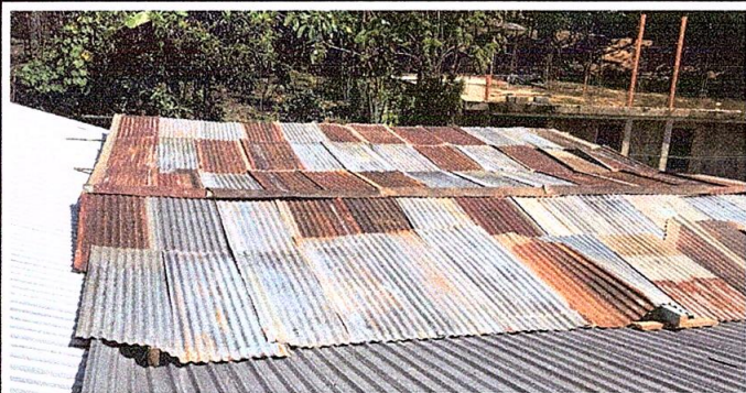
Foto1: Láminas y capotes en malas condiciones
