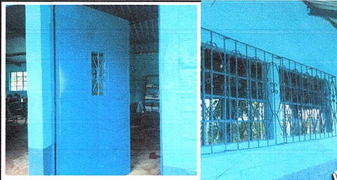
Foto 2: Puertas de metal Y Ventanas
