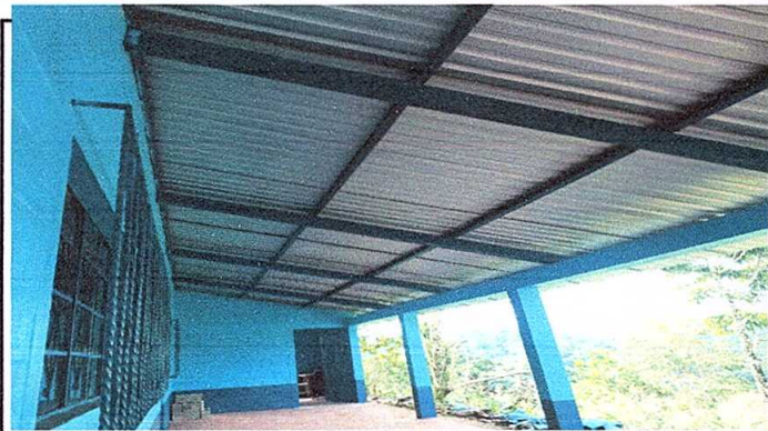
Foto 3: canales y bajadas de agua
