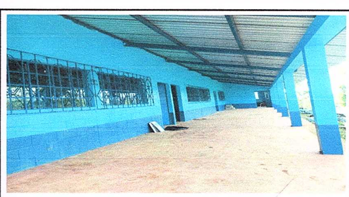
Foto 4: Pintura interior y exterior muros Perimetrales
