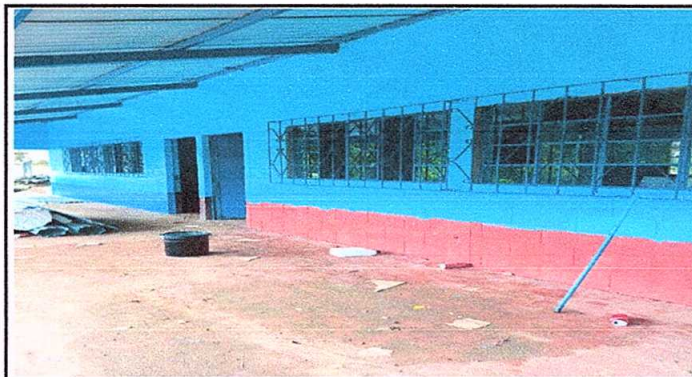
Foto 4: Pintura interior y exterior muros Perimetrales
