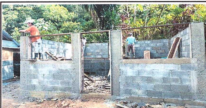
Foto 5: Construcción de cocina
