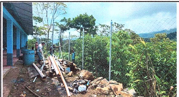
Foto 3: canales y bajadas de agua
