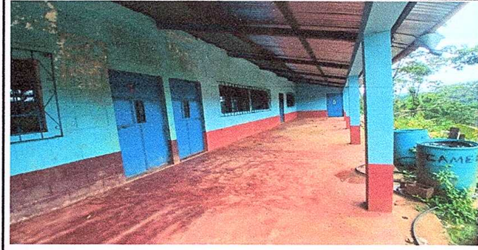
Foto 4: Pintura interior y exterior muros Perimetrales
