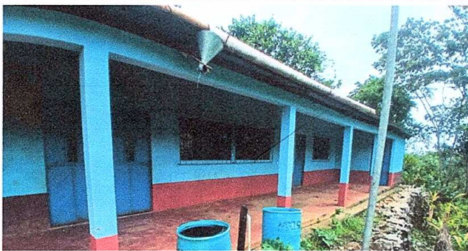
Foto 3: canales y bajadas de agua
