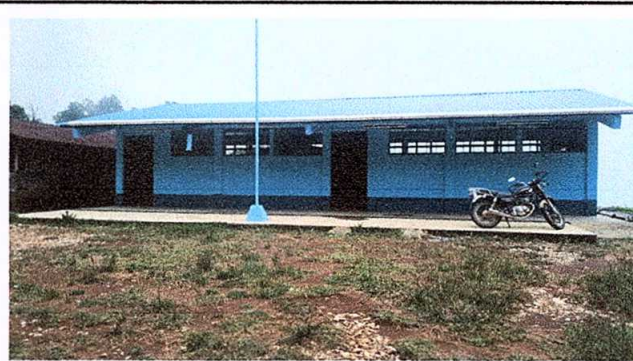
Foto 8: Pintura en mal estado
