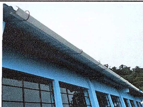
Foto 6: Canales en mal estado
