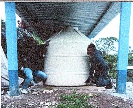
Foto 9: Rotoplas en mal estado
