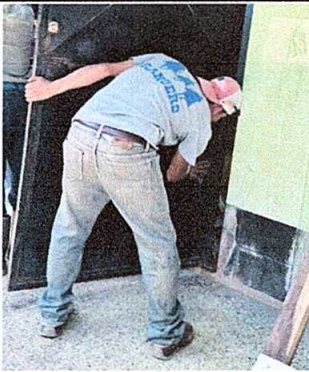
Foto 3: Pintura de puerta deteriorada
