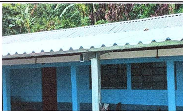
6. CUBIERTA DE LAMINA. Sustitución de elementos de fijación.
