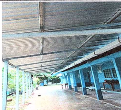
2. ESTRUCTURA DE TECHO. Sustitución de estructura de soporte de madera por metal.
