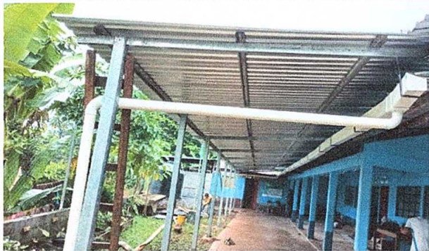
1. CUBIERTA DE LAMINA. Sustitución de lámina por láminas troqueladas.
