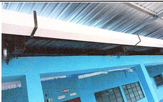
5. CANALES Y BAJADAS DE AGUA PLUVIAL. Sustitución de canal de PVC.
