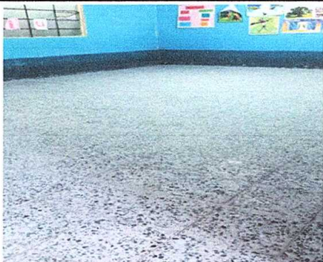
3. PISO. Sustitución de piso de granito.
