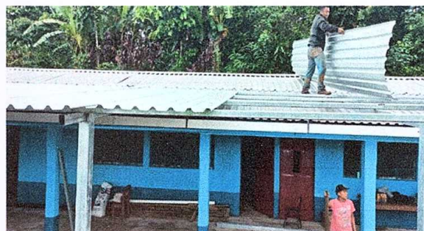
6. CUBIERTA DE LAMINA. Sustitución de elementos de fijación.
