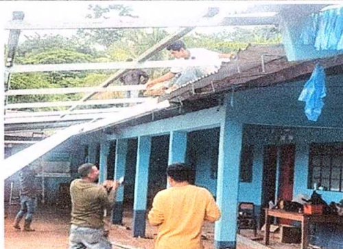
4. CANALES Y BAJADAS DE AGUA PLUVIAL. Sustitución de soporte o pescante de PVC para canal.
