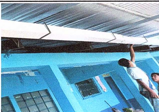
5. CANALES Y BAJADAS DE AGUA PLUVIAL. Sustitución de canal de PVC.
