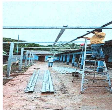
2. ESTRUCTURA DE TECHO. Sustitución de estructura de soporte de madera por metal.
