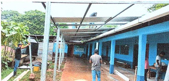
1. CUBIERTA DE LAMINA. Sustitución de lámina por láminas troqueladas.
