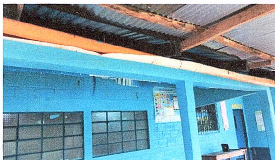
5. CANALES Y BAJADAS DE AGUA PLUVIAL. Sustitución de canal de PVC
