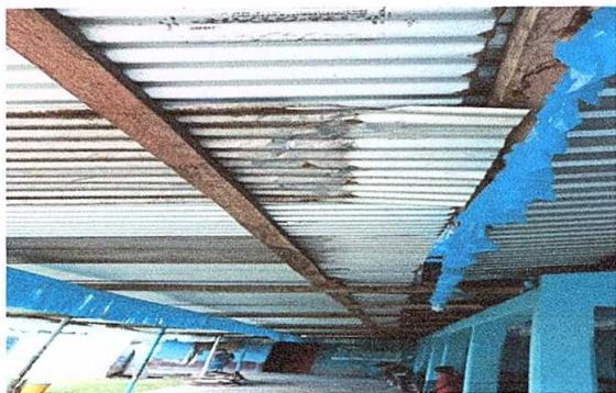
1. CUBIERTA DE LAMINA. Sustitución de lámina por lámina troqueladas.
