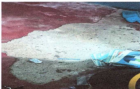
3. PISO Sustitución de piso de granito.
