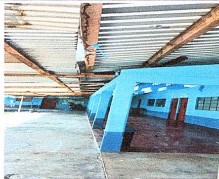
4. CANALES Y BAJADAS DE AGUA PLUVIAL Sustitución de soporte o pesacante de PVC para canal.
