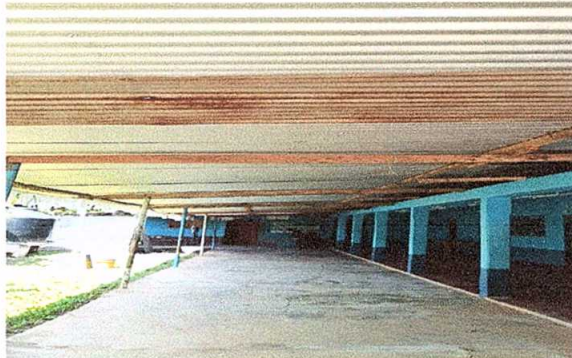
2. ESTRUCTURA DE TECHO. Sustitución de estructura de soporte de madera por metal
