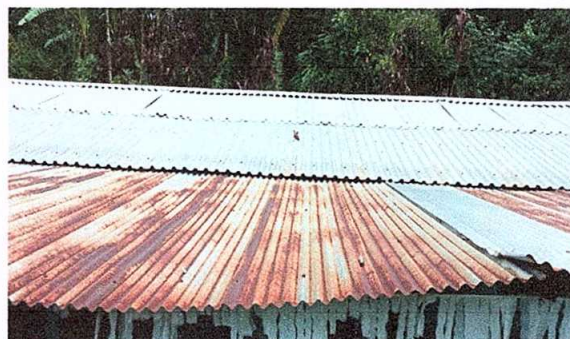
6. CUBIERTA DE LÁMINA. Sustitución de elementos de fijación
