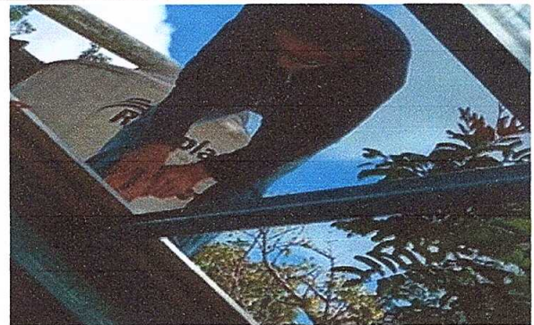
Foto 4: Estructura de madera en malas condiciones
