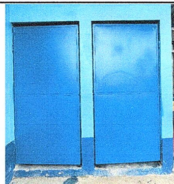
FOTO 4: Sustrucción de puerta en servicios sanitarios de 1.50 mts. de alto x 0.75 mts. de ancho
