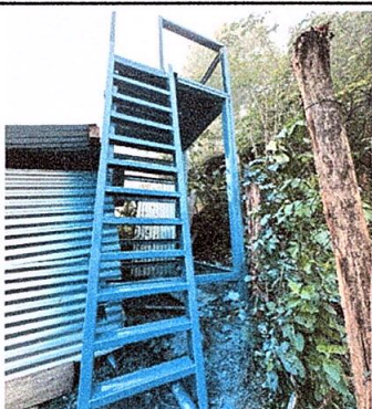
Foto 3: Mantenimiento y pintura para estructura de depósito de agua
