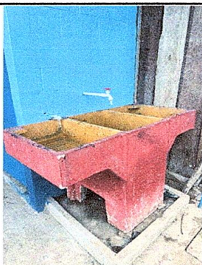
FOTO 9: Sustitución de pila de cemento de dos lavaderos
