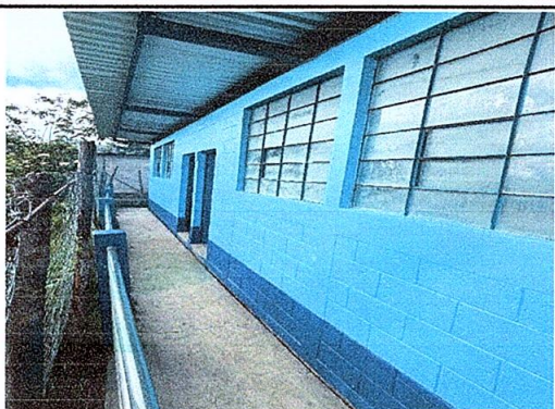
FOTO 7: Pintura en muros exteriores e interiores
