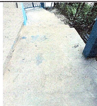
FOTO 6: Sustrucción de piso de torta de concreto
