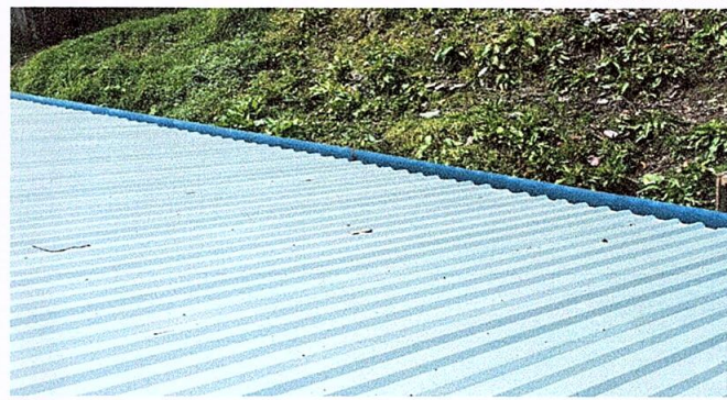
Foto 2: Sustitución de canal de metal
