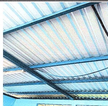
FOTO 2: Sustrucción de estructura de soporte de metal, por metal
