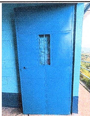
FOTO 3: Sustrucción de puerta de 2.10 mts. de alto x 1 mt. de ancho
