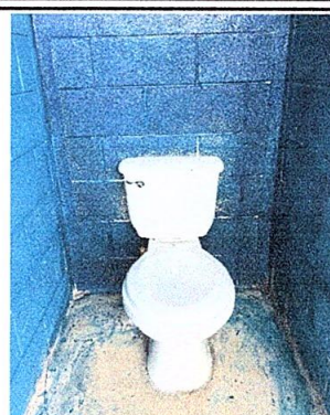
FOTO 8: Sustitución de inodoro
