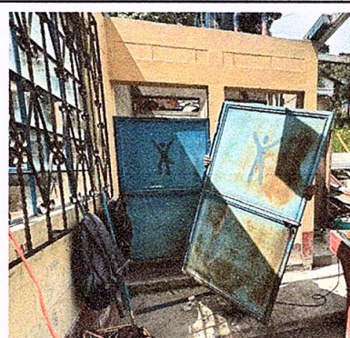
FOTO 4: Sustitución de puerta en servicios sanitarios de 1.50 mts. de alto x 0.75 mts. de ancho
