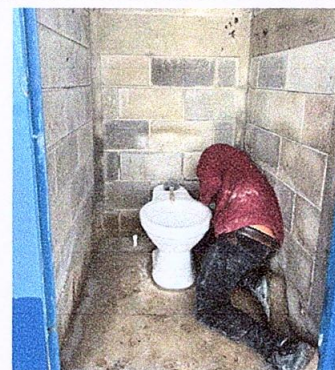
FOTO 8: Sustitución de inodoro
