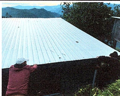
Foto 2: Sustitución de canal de metal
