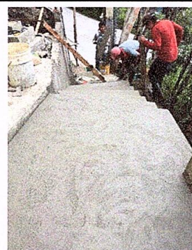
FOTO 6: Sustitución de piso de torta de concreto
