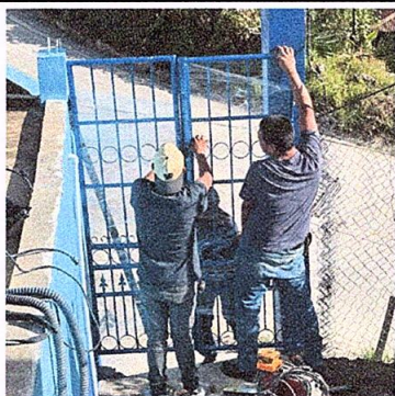
FOTO 5: Sustitución de portón de metal de 2 mts. de alto x 1.50 mts. de ancho
