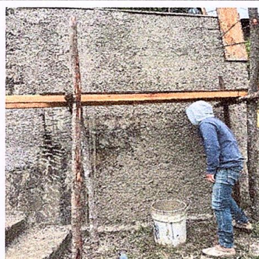
FOTO 10: Repello en muro
