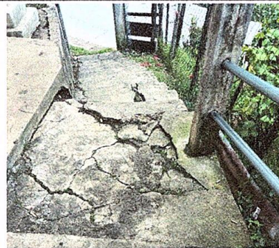
FOTO 6: Sustrucción de piso de torta de concreto
