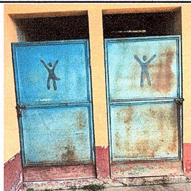
FOTO 4: Sustrucción de puerta en servicios sanitarios de 1.50 mts. de alto x 0.75 mts. de ancho
