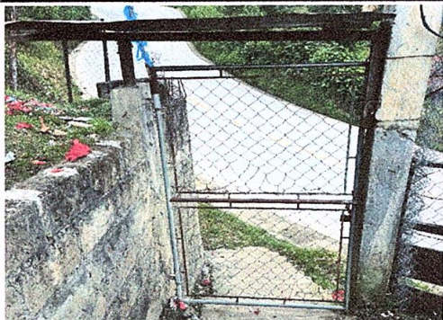
FOTO 5: Sustrucción de portón de metal de 2 mts. de alto x 1.50 mts. de ancho
