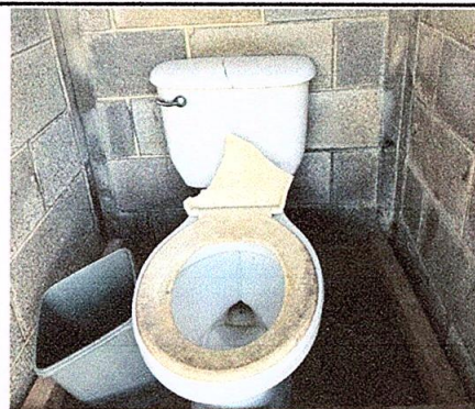
FOTO 8: Sustitución de inodoro
