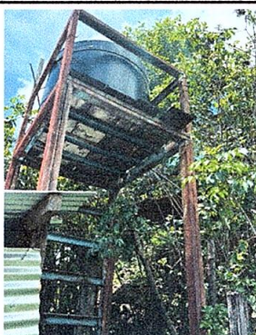
Foto 3: Mantenimiento y pintura para estructura de depósito de agua
