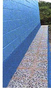
Foto 2: Sustitución de piso de torta de concreto por granito.
