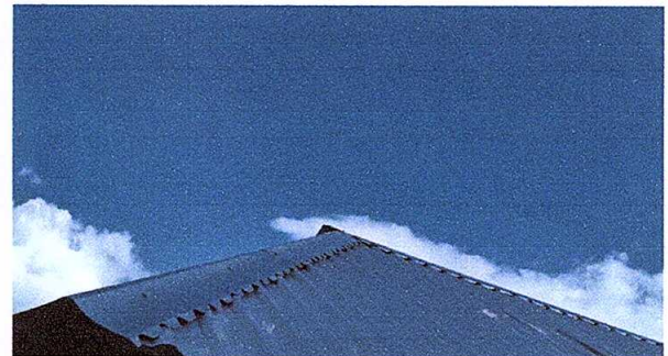
Foto 6: Sustitución de capote de lámina troquelada
