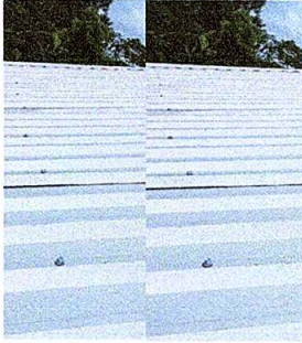
Foto7: Sustitución de elementos de fijación.
