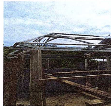
Foto 4: Sustitución de estructura de soporte de madera, por metal.
