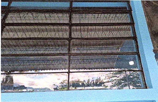
Foto1: Mantenimiento a estructura de metal de ventanas.
