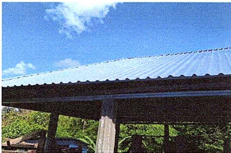
Foto 5: Sustitución de lámina, por lámina troquelada.
