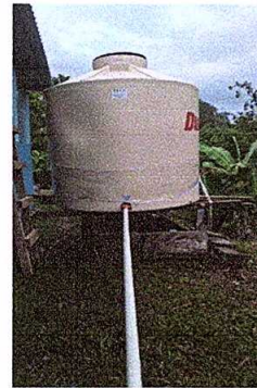
FOTO 10: Reparación y mantenimiento de cisternas/ deposito de agua.
