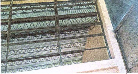
Foto1: Mantenimiento a estructura de metal de ventanas.
