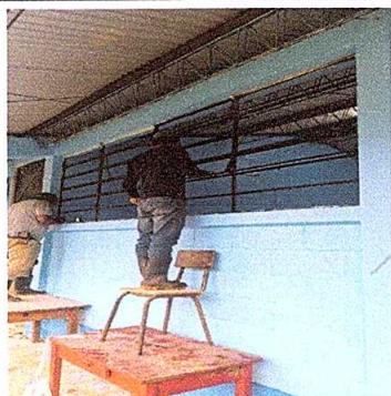
Foto 9: Mantenimiento de estructura de metal de ventanas e instalación de estructura metálica en techo de cocina.
