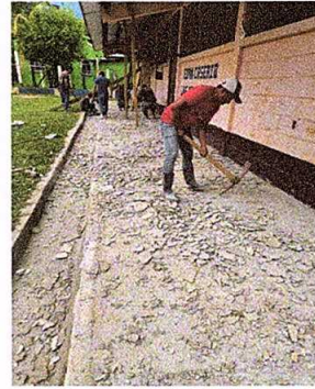
Foto 2: Sustitución de piso de torta de concreto por granito.
