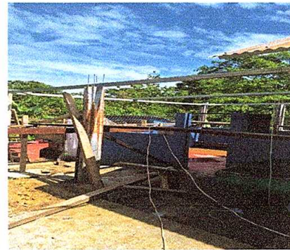
Foto 4: Sustitución de estructura de soporte de madera, por metal.
