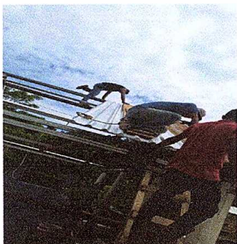
Foto7: Sustitución de elementos de fijación.
