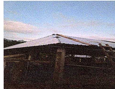
Foto 6: Sustitución de capote de lámina troquelada
