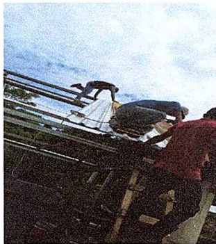
Foto 5: Sustitución de lámina, por lámina troquelada.
