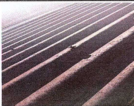
Foto 5: Sustitución de lámina, por lámina troquelada.
