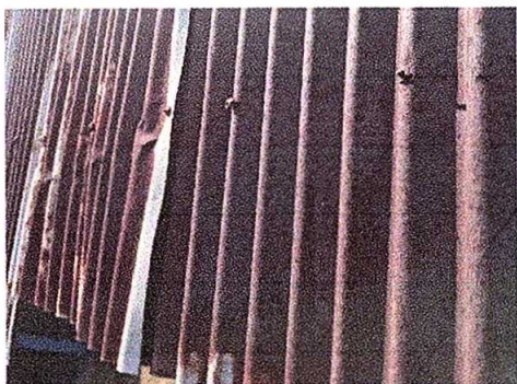
Foto7: Sustitución de elementos de fijación.
