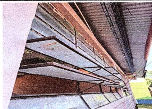
Foto 9: Mantenimiento de estructura de metal de ventanas e instalación de estructura metálica en techo de cocina.
