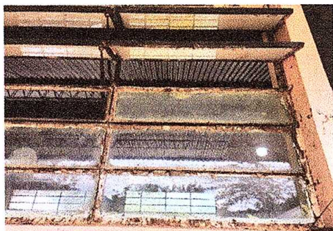
Foto1: Mantenimiento a estructura de metal de ventanas.
