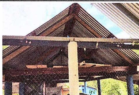
Foto 4: Sustitución de estructura de soporte de madera, por metal.
