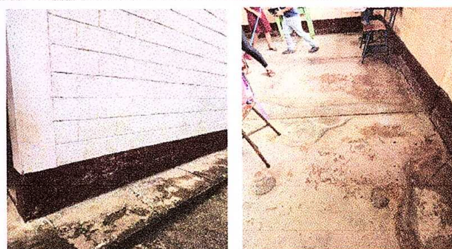
Foto 2: Sustitución de piso de torta de concreto por granito.
