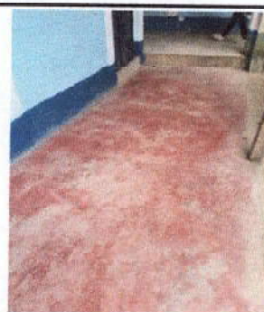
Foto 6: Sustitución de piso por piso de granito
