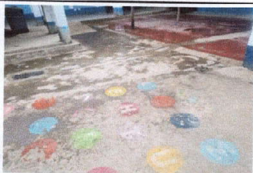
Foto 5: Reparación de piso de torta de concreto
