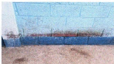
Foto 13: Pintura en muros exteriores e interiores
