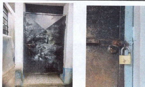
Foto 4: Sustitución de puertas de 1 por 2.25 metros
