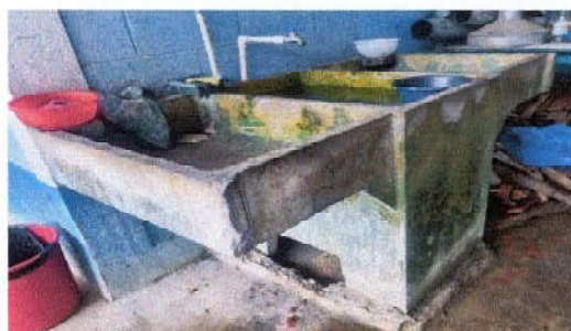
Foto 8: Sustrucción de pila de cemento de 2 lavaderos
