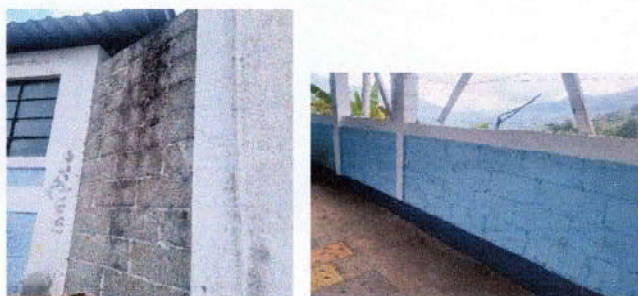
Foto 9: Repello en muro
