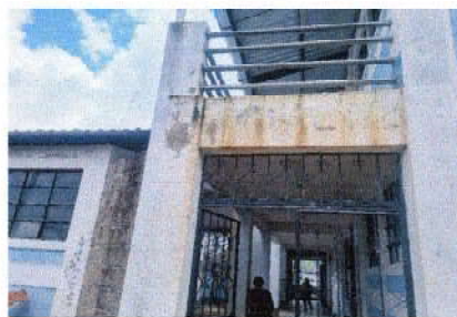
Foto 14: Pintura en muros exteriores e interiores
