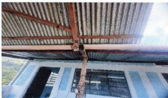
Foto 7: Sustrucción de canal de metal
