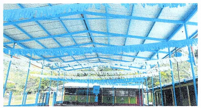
Foto 4: Tubo PVC y tubo galvanizado en malas condiciones.
