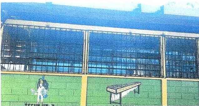
Foto 5: Ventanas sin balcones.
