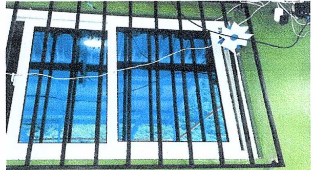
Foto 6: Ventanas sin balcones.
