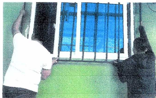
Foto 6: Ventanas sin balcones.
