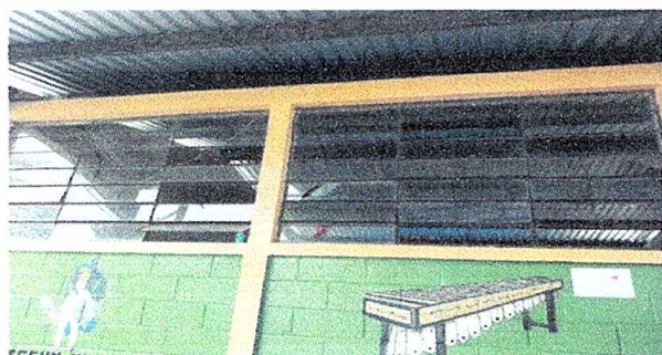
Foto 5: Ventanas sin balcones
