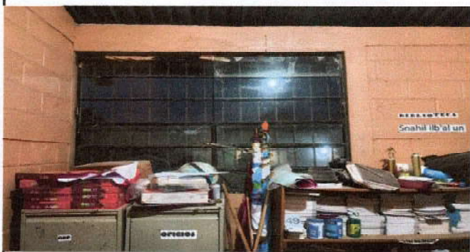
Foto1: Sustitución de ventana dirección
