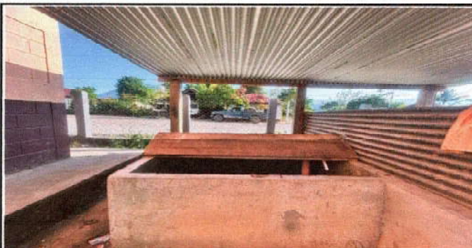
Foto 5: Reparación de tanque
