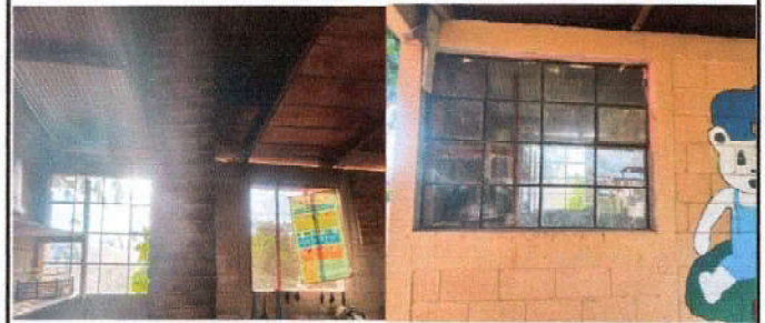
Foto 2: sustitución de ventanas por pvc
