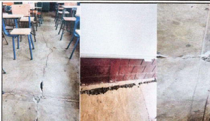
Foto 2: Sustitución de piso, por piso de granito, de dos aulas y cocina en mal estado
