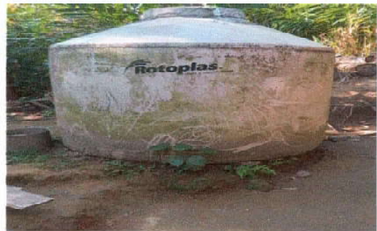
Foto 4: sustitución de tinaco
