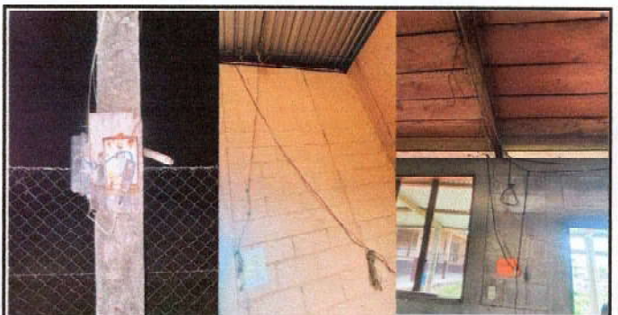
Foto 6: Sustitución de flipón y cableado en mal estado.
