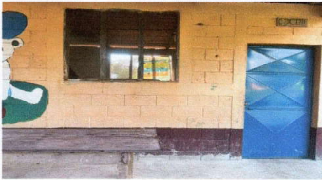
Foto1: sustitución de ventana de madera, por pvc corrediza
