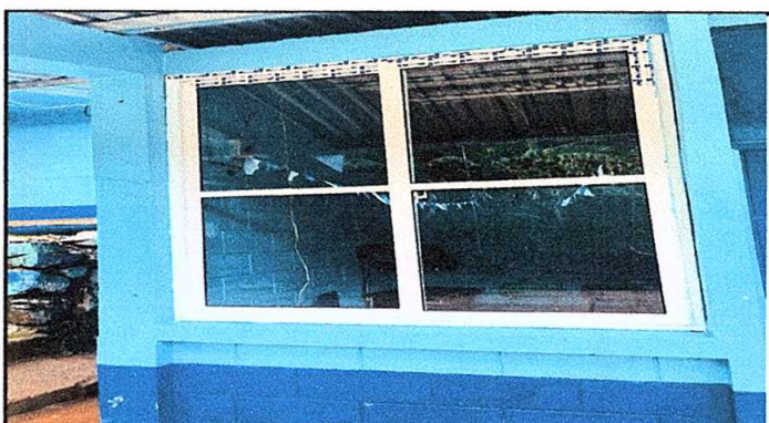
Foto 4: sustitución de una ventana de 3 mts alto x 1.7 mts ancho en la dirección
