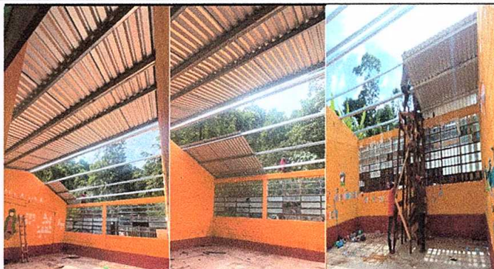
Foto 2: Sustitución de Capotes de lamina para lamina troquelada, estructura de soporte de metal y elementos de fijación en cuatro aulas y dirección
