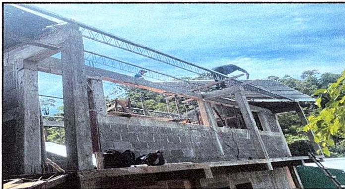
Foto 7: mejoramiento de pared
