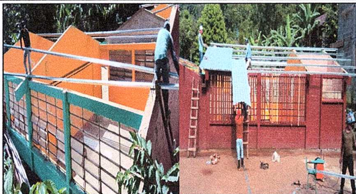
Foto1: Sustitución de lámina por lámina troquelada aluzinc calibre 26, en cuatro aulas y dirección de la escuela.
