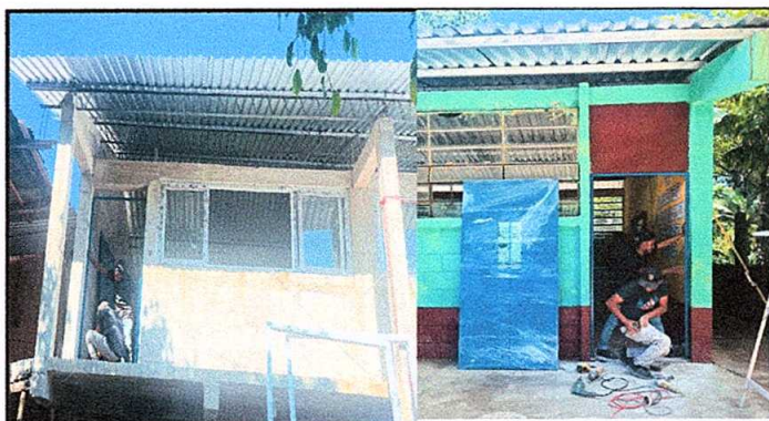
Foto 3: Sustitucion de dos puertas de 2.10 mts alto x 1 mts de ancho en dos aulas.
