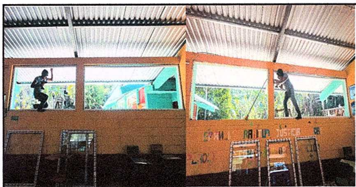
Foto 5: sustitución de cuatro ventanas de 1.25 mts de alto x 3 mts de ancho en dos aulas.
