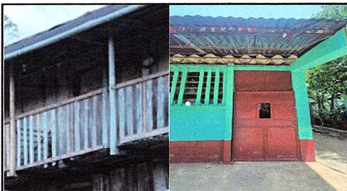
Foto 3: Sustrucción de dos puertas de 2.10 mts alto x 1 mts de ancho en dos aulas.
