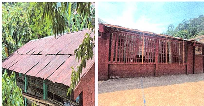
Foto1: Sustrucción de lámina por lámina troquelada aluzinc calibre 26, en cuatro aulas y dirección de la escuela.
