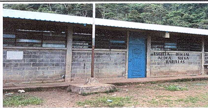
Foto 5: Sustrucción de puerta (2.09 m de alto * 0.97m de ancho)
