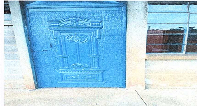
Foto 4: Sustrucción de puerta (2.09m de alto * 0.97m de ancho)
