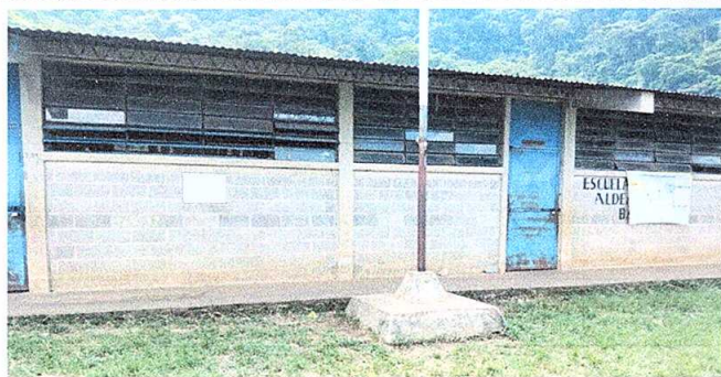
Foto 5: Pintura en muros exteriores e interiores
