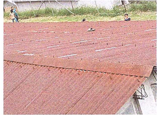
Foto 2: Sustitución de capote de lámina para lámina troquelada
