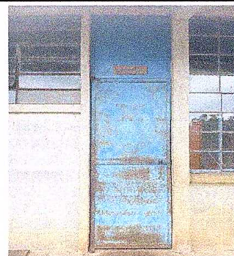
Foto 4: Sustitución de puerta (2.09m de alto * 0.97m de ancho)
