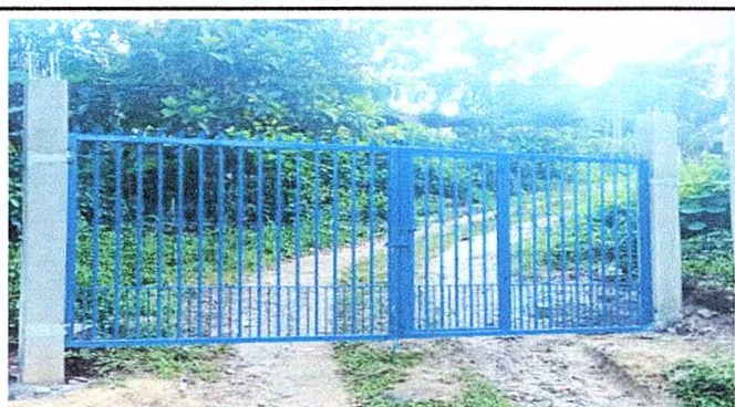
Foto 9: Sustitución de portón de metal.
