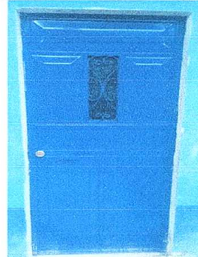
Foto 2: Sustrucción de puertas de madera por metal.
