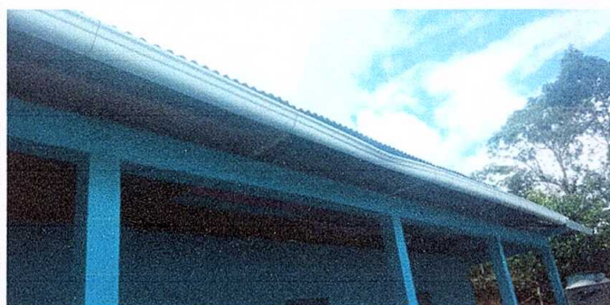
Foto 5: Sustrucción de canal de PVC.
