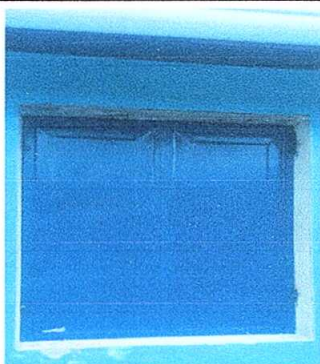
Foto 3: Sustrucción de ventanas de madera por metal.
