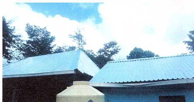
Foto 1: Sustrucción de lámina por lámina troquelada aluzinc calibre 26 y sustrucción de capote por lámina para lámina troquelada.
