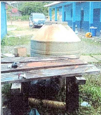
Foto7: Sustitución de depósito de agua 2500 lt.
