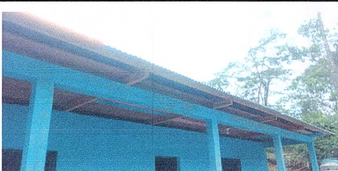
Foto 5: Sustitución de canal de PVC.
