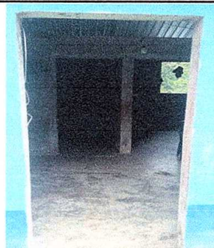
Foto 2: Sustitución de puertas de madera por metal.
