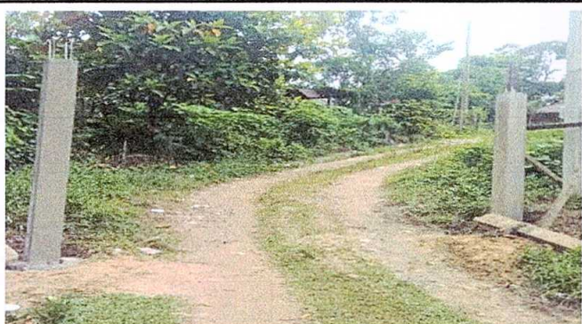
Foto 9: Sustitución de portón de metal.
