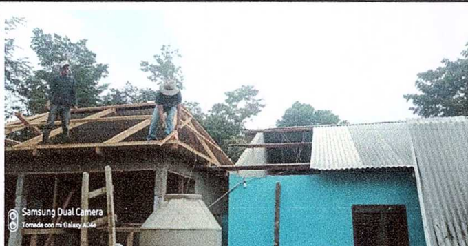
Foto 1: Sustitución de lámina por lámina troquelada aluzinc calibre 26 y sustitución de capote por lámina para lámina troquelada.
