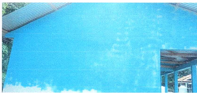
Foto 6: Aplicación de pinturas en paredes exteriores e interiores.
