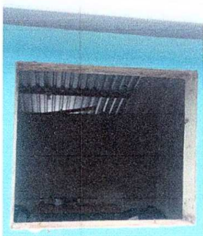
Foto 3: Sustitución de ventanas de madera por metal.
