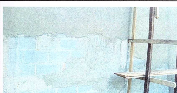
Foto 8: Sustitución de repello en paredes.
