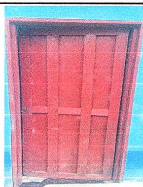
Foto 2: Sustitución de puertas de madera por metal.
