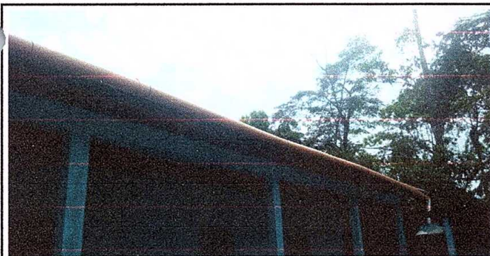
Foto 5: Sustitución de canal de PVC.
