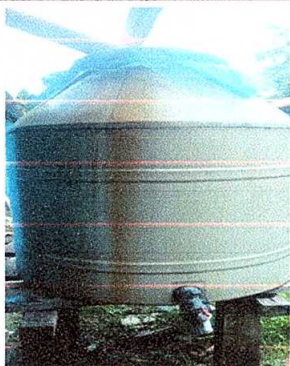
Foto7: Sustitución de depósito de agua 2500 lt.
