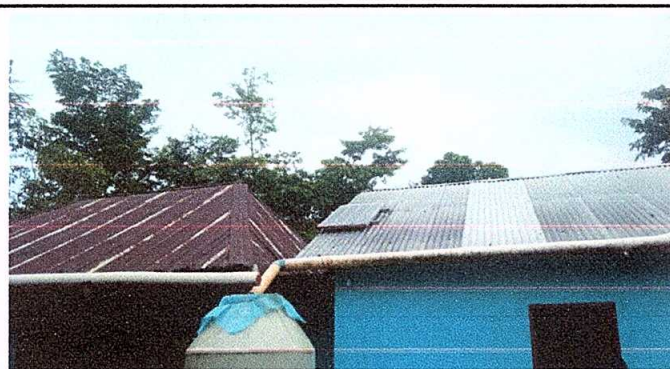
Foto 1: Sustitución de lámina por lámina troquelada aluzinc calibre 26 y sustitución de capote por lámina para lámina troquelada.
