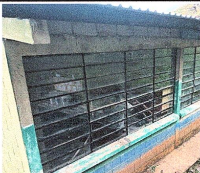
Foto 5: Sustitución de vidrios.
