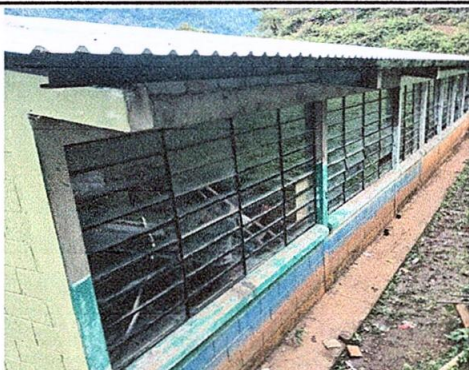
Foto 3: Mantenimiento a estructura de metal de ventana.
