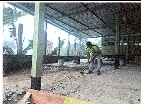
Foto 6: Sustitución de piso de torta de concreto.
