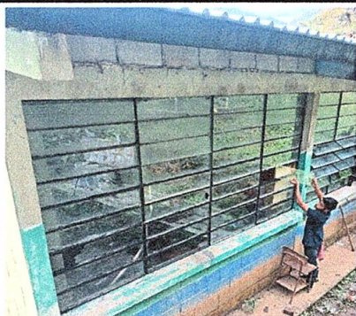
Foto 5: Sustitución de vidrios.
