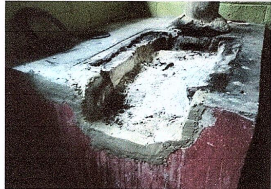
Foto 8: Sustitución de plancha de metal de 3 hornillas.
