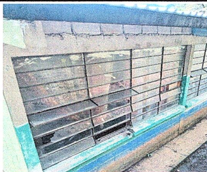
Foto 5: Sustitución de vidrios.
