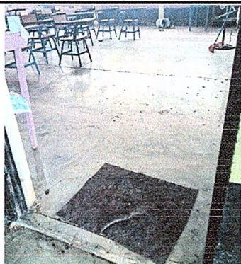
Foto 7: Sustitución de piso de granito.
