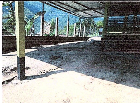
Foto 6: Sustitución de piso de torta de concreto.
