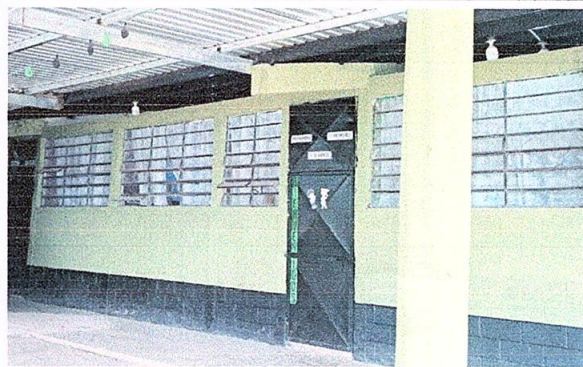
Foto 4: Sustitución de estructura de metal de ventana.
