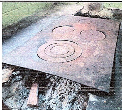
Foto 8: Sustitución de plancha de metal de 3 hornillas.
