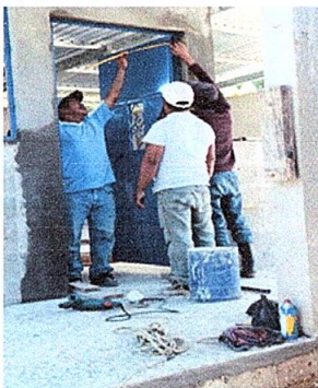
FOTO 5: Sustitución de puerta (2.10m de alto * 1.00m de ancho)
