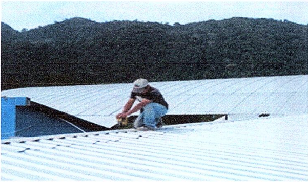
FOTO 1: CUBIERTA DE LAMINA
