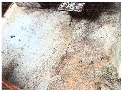
FOTO 3: Sustitución de piso de granito
