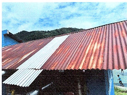
FOTO 1: CUBIERTA DE LAMINA
