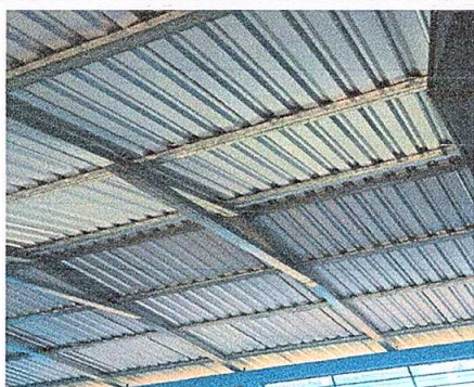
FOTO No. 3: Sustrucción de estructura de soporte de madera, por metal
