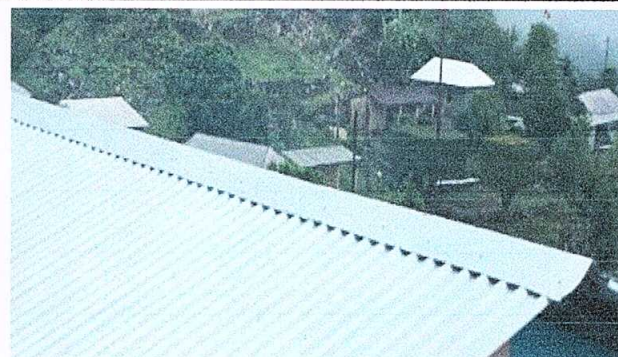
FOTO No. 2: Sustrucción de capote de lámina para lámina troquelada
