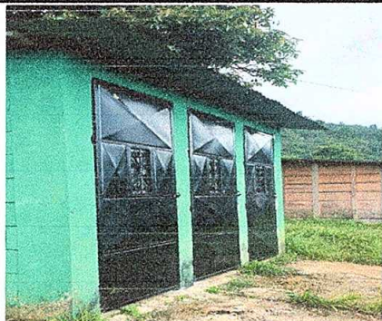
FOTO No. 5: Sustrucción de puerta en servicios sanitarios
