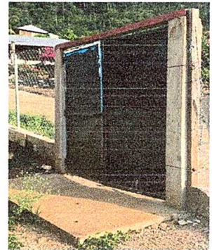
FOTO No. 4: Sustitución de puerta (2.01m de alto * 0.95m de ancho)
