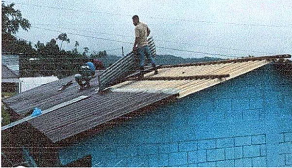
FOTO No. 1: Sustitución de lámina, por lámina troquelada aluzinc calibre 26
