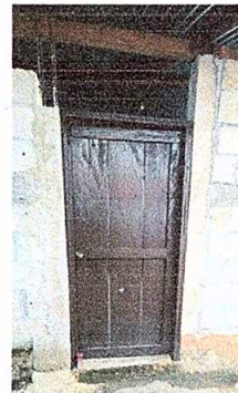
FOTO No. 4: Sustitución de puerta (2.01m de alto * 0.95m de ancho)
