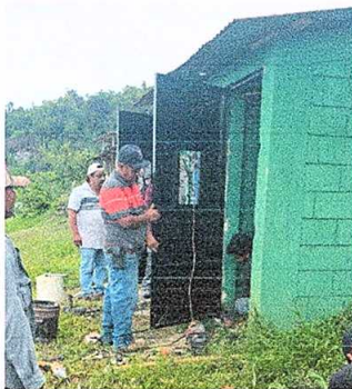
FOTO No. 5: Sustitución de puerta en servicios sanitarios
