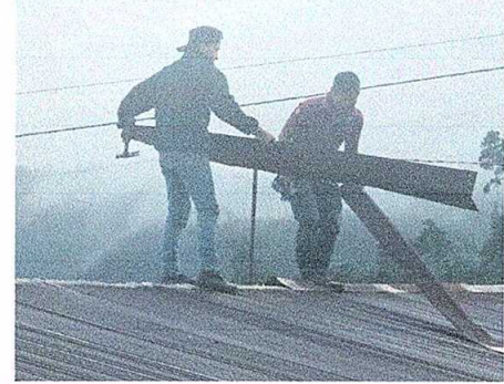
FOTO No. 2: Sustitución de capote de lámina para lámina troquelada
