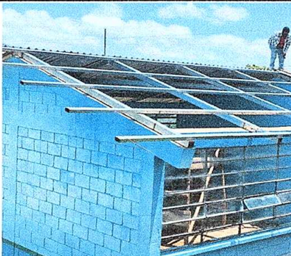
FOTO No. 3: Sustitución de estructura de soporte de madera, por metal
