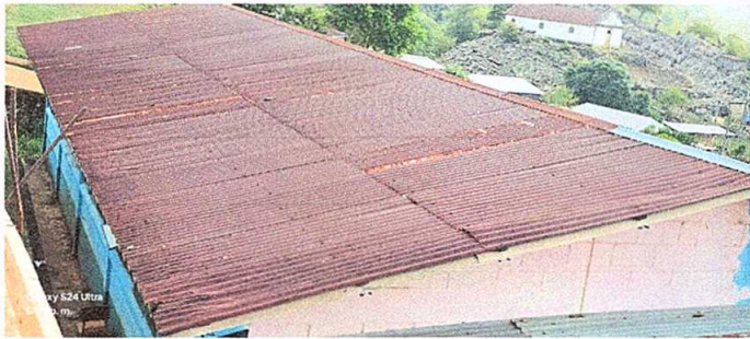
FOTO No. 1: Sustrucción de lámina, por lámina troquelada aluzinc calibre 26
