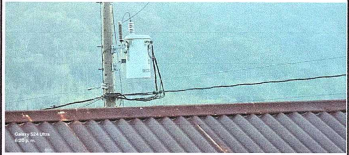
FOTO No. 2: Sustrucción de capote de lámina para lámina troquelada
