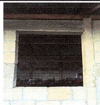
FOTO No. 6: Sustrucción de ventanas de madera por metal mas vidrio
