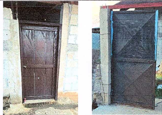
FOTO No. 4: Sustrucción de puerta (2.01m de alto * 0.95m de ancho)
