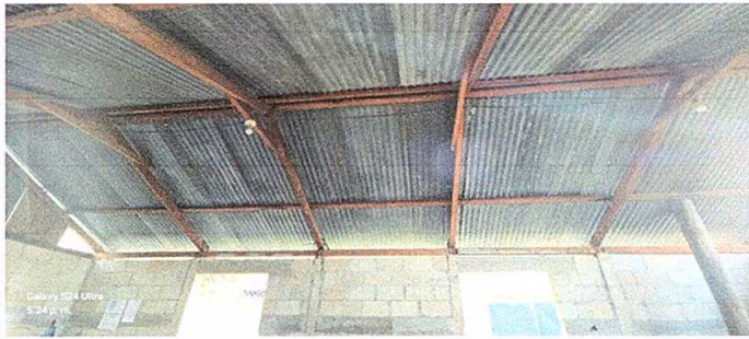
FOTO No. 3: Sustrucción de estructura de soporte de madera, por metal
