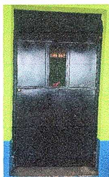
Foto 5: Mantenimiento a estructura de cocina, 2.20 metros de alto por 1 metro de ancho, Sustrucción de chapa.
