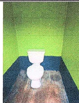
Foto 2: Sustrución de inodoro
