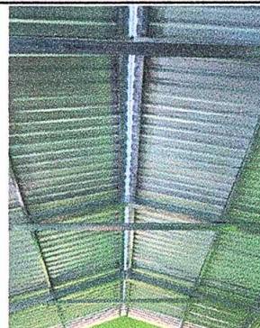
foto 2: Sustrucción de estructura de soporte de madera, por metal
