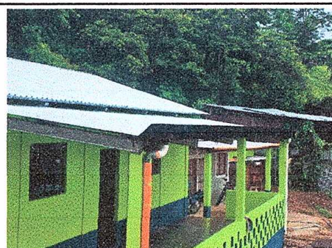
Foto 4: Sustrucción de canal de pvc por canal de metal (calibre 3.63), reparación de bajada de agua pluvial, tubo PVC 3" y sustrucción de soporte o pescante de metal para canal.
