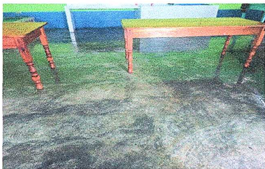
Foto 1: Sustrución de piso de torta de concreto.
