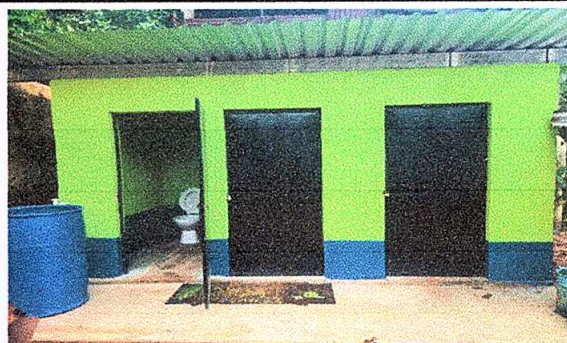
Foto 6: Sustrucción de puertas en servicios sanitarios, 1.75 metros de alto por 80 cmts.
