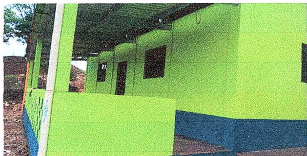
Foto 5: Pintura en muros exteriores e interiores
