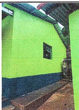
Foto 3: Sustrucción de ventanas de madera por metal mas vidrio de 1 mt de alto x 1.30 mt de ancho
