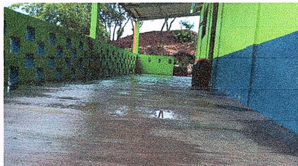
Foto 4: Sustrución de piso de torta de concreto del corredor
