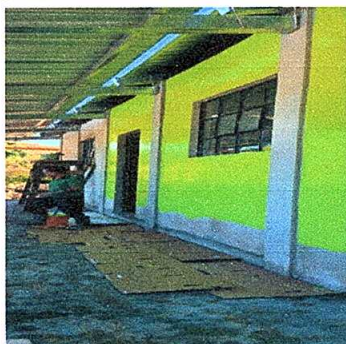
Foto 5: Pintura en muros exteriores e interiores
