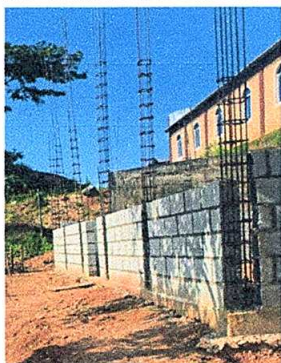
Foto 3: Mejoramiento de pared en cocina
