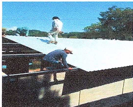
foto 1: Sustitución de lámina, por lámina troquelada aluzinc calibre 26, sustitución de capote de lámina para lámina troquelada y sustitución de elementos de fijación.
