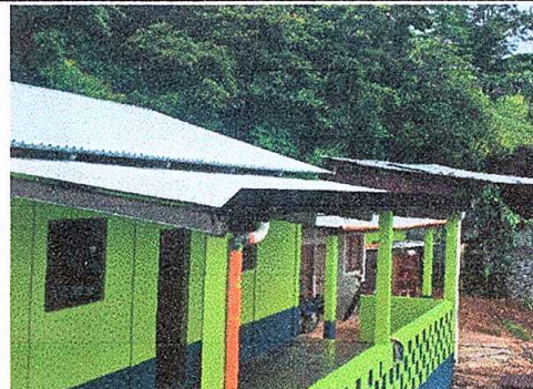
Foto 4: Sustitución de canal de pvc por canal de metal (calibre 3.63), reparación de bajada de agua pluvial, tubo PVC 3" y sustitución de soporte o pescante de metal para canal.
