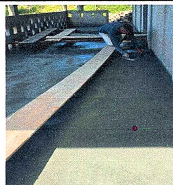
Foto 4: Sustitución de piso de torta de concreto del corredor
