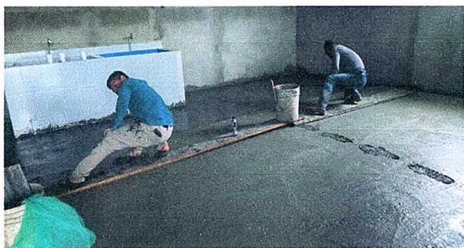
Foto 1: Sustitución de piso de torta de concreto.
