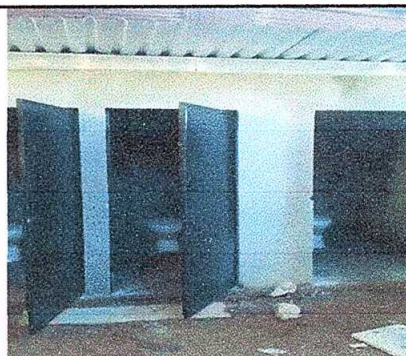
Foto 6: Sustitución de puertas en servicios sanitarios, 1.75 metros de alto por 80 cmts.
