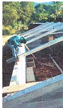
foto 2: Sustitución de estructura de soporte de madera, por metal
