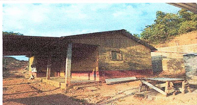
Foto 3: Sustitución de ventanas de madera por metal mas vidrio de 1 mt de alto x 1.30 mt de ancho
