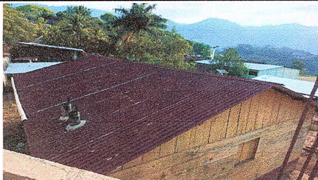
foto 1: Sustitución de lámina, por lámina troquelada aluzinc calibre 26, sustitución de capote de lámina para lámina troquelada y sustitución de elementos de fijación.
