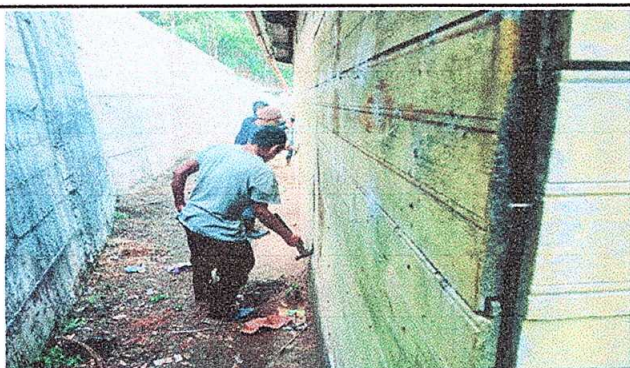
Foto 3: Mejoramiento de pared en cocina
