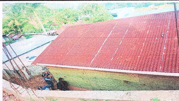
Foto 4: Sustitución de canal de pvc por canal de metal (calibre 3.63), reparación de bajada de agua pluvial, tubo PVC 3" y sustitución de soporte o pescante de metal para canal.
