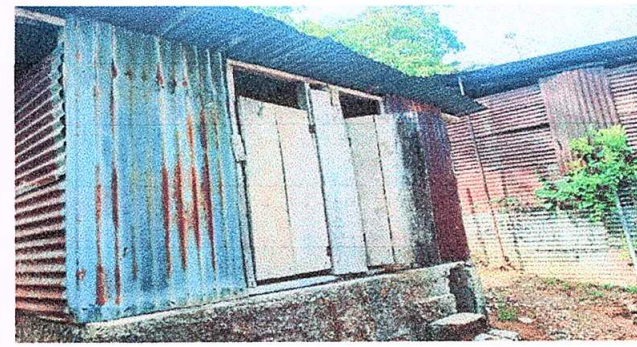
Foto 6: Sustitución de puertas en servicios sanitarios, 1.75 metros de alto por 80 cmts.
