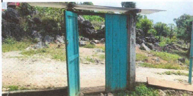
Foto 7: Sustrucción de portón de madera a metal 1.60 X 2.10
