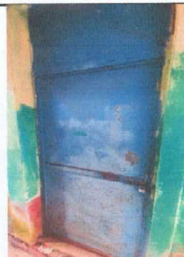
Foto 4: Mantenimiento de estructura de puerta (lijado, cambio de tubo, sujetiones y aplicación de pintura)
