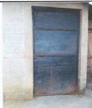
Foto 6: Sustitución de Puerta de metal por metal 2.10 X 95
