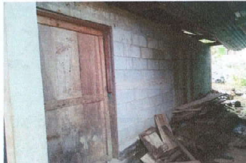
Foto 14: Mejoramiento de repello
