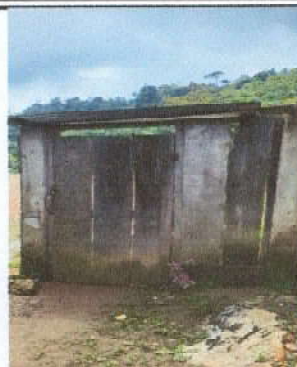
Foto 8: Sustrucción de portón de madera a metal 1.60 X 2.10
