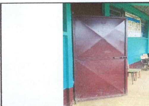
Foto 5: Mantenimiento de estructura de puerta (lijado, cambio de tubo, sujetiones y aplicación de pintura)
