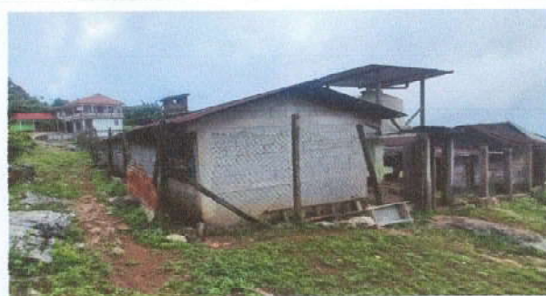
Foto 12: Reparación de tubo hg y malla galvanizada
