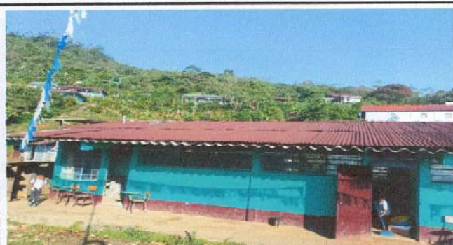
Foto 11: Pintura en muros interiores y exteriores
