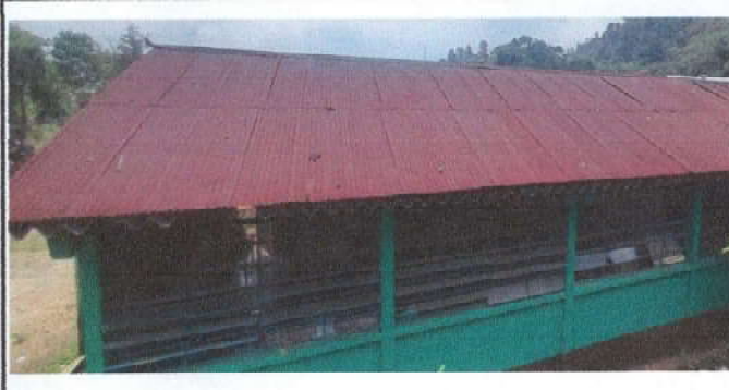
Foto 2: sustitución de capotes de lámina para lámina troquelada
