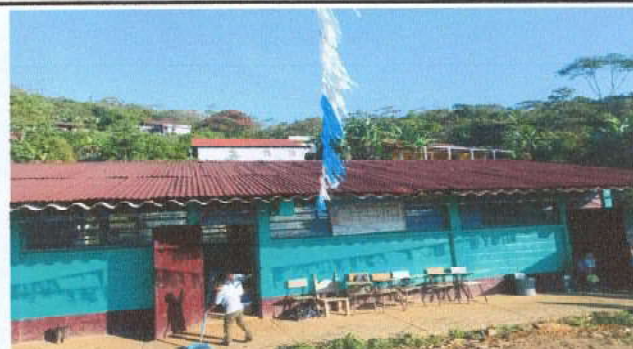
Foto 10: Sustrucción de canal de pvc
