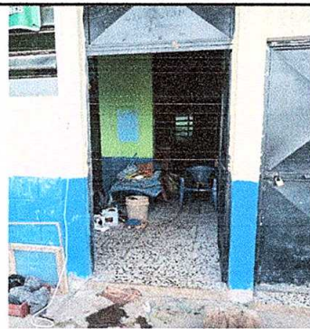
Foto 6: Sustrucción de piso de granito.
