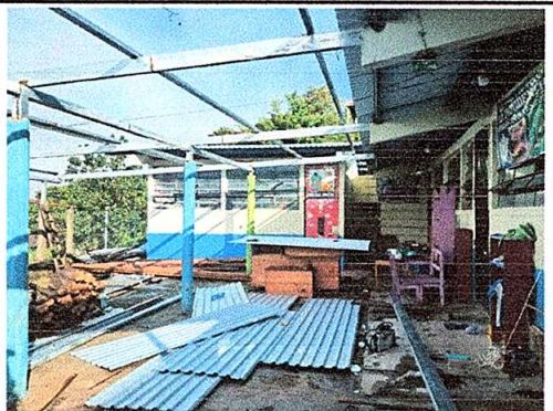
Foto 4: Sustrucción de estructura de soporte de madera, por metal.
