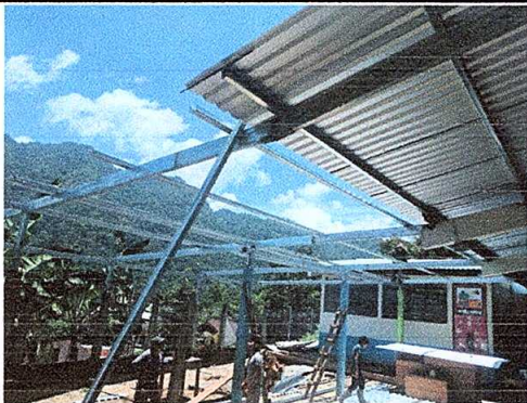
Foto 3: Sustrucción de estructura de soporte de madera, por metal.
